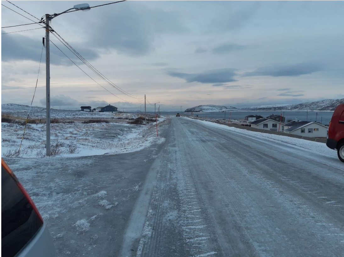
Bildet viser tilfredsstillende siktkrav i vestgående retning
