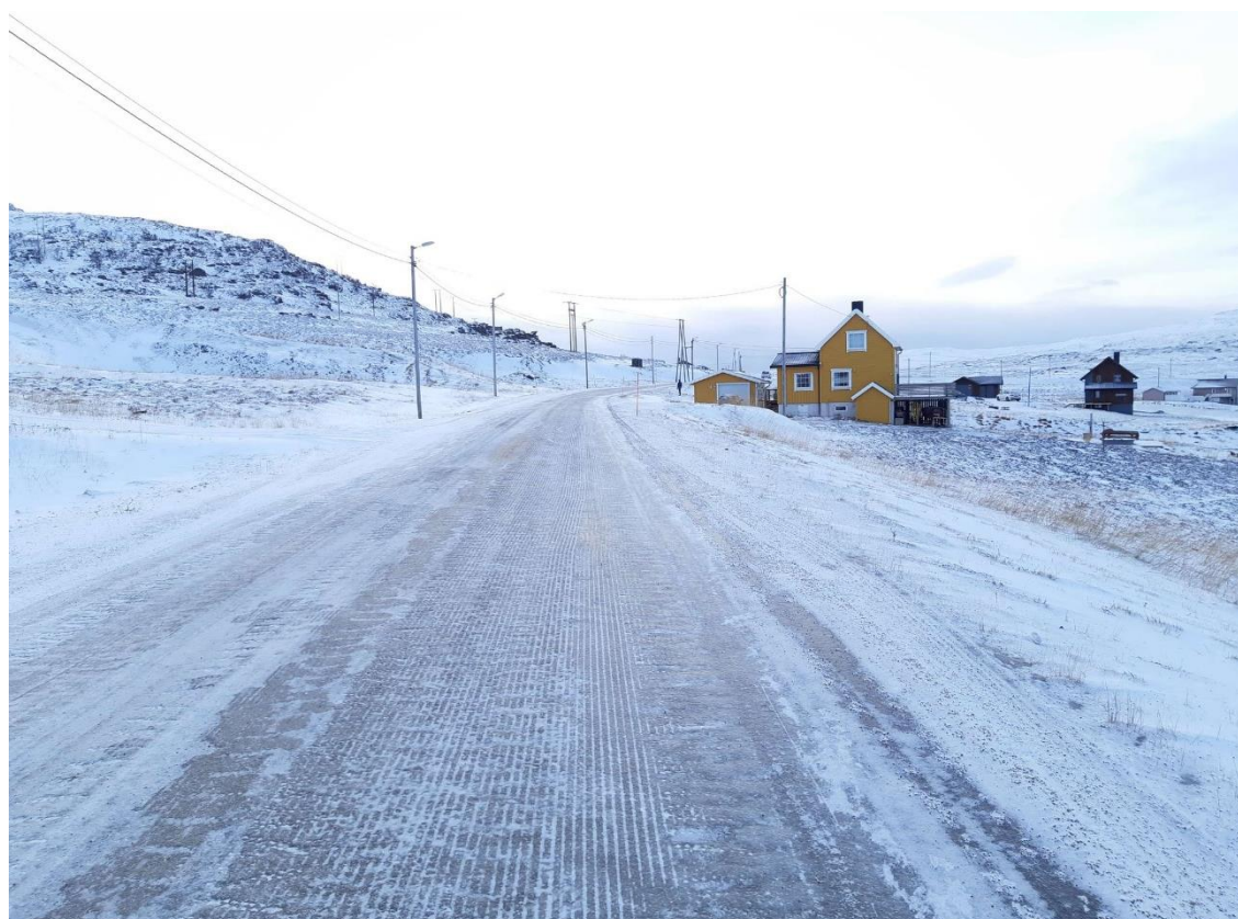
Bildet viser tilfredsstillende siktkrav fra veibanen (sørgående).
