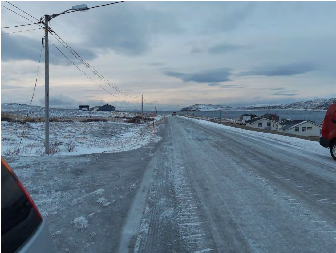
Bildet viser tilfredsstillende siktkrav i vestgående retning
