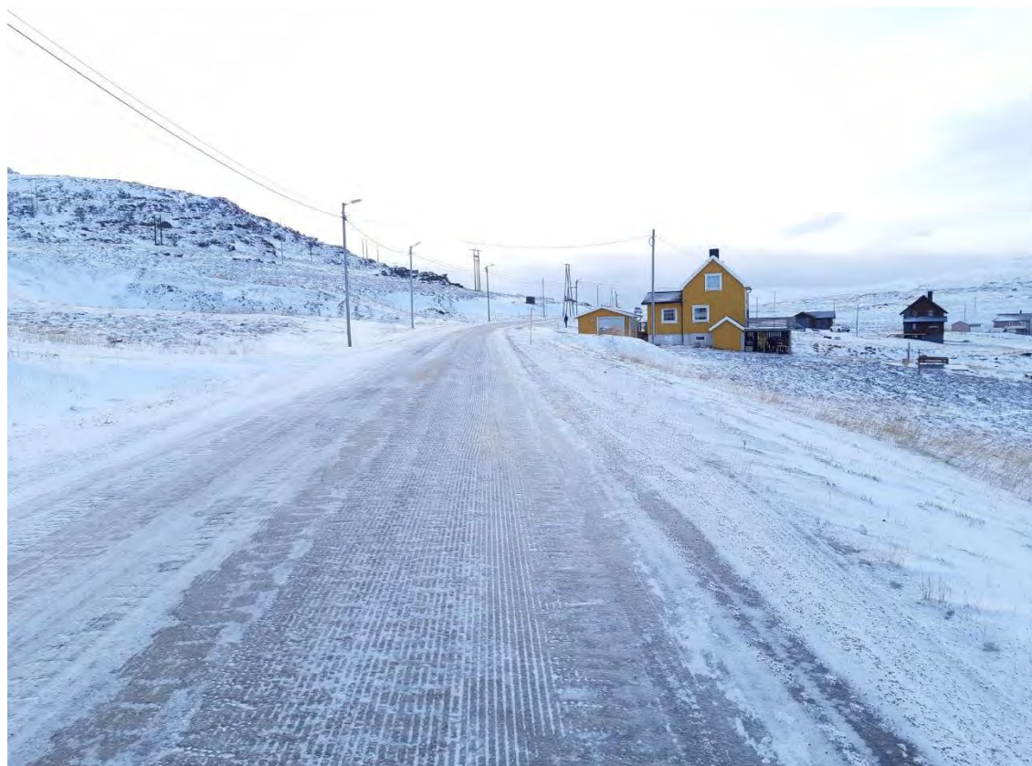
Bildet viser tilfredsstillende siktkrav fra veibanen (sørgående).
