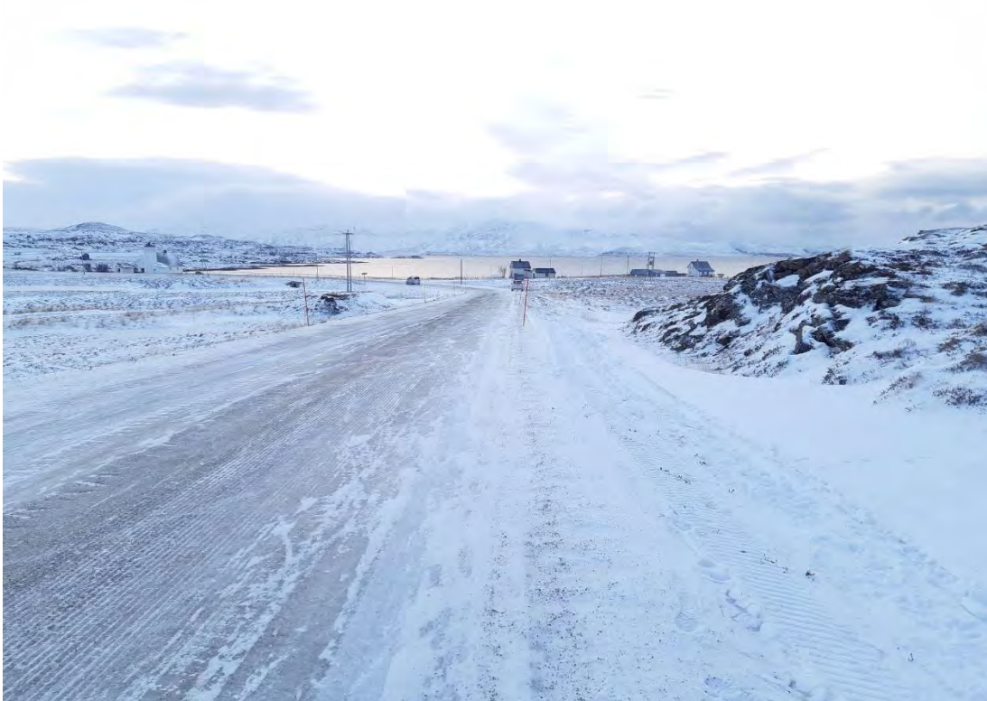
Bildet viser tilfredsstillende siktkrav sørgående retning
