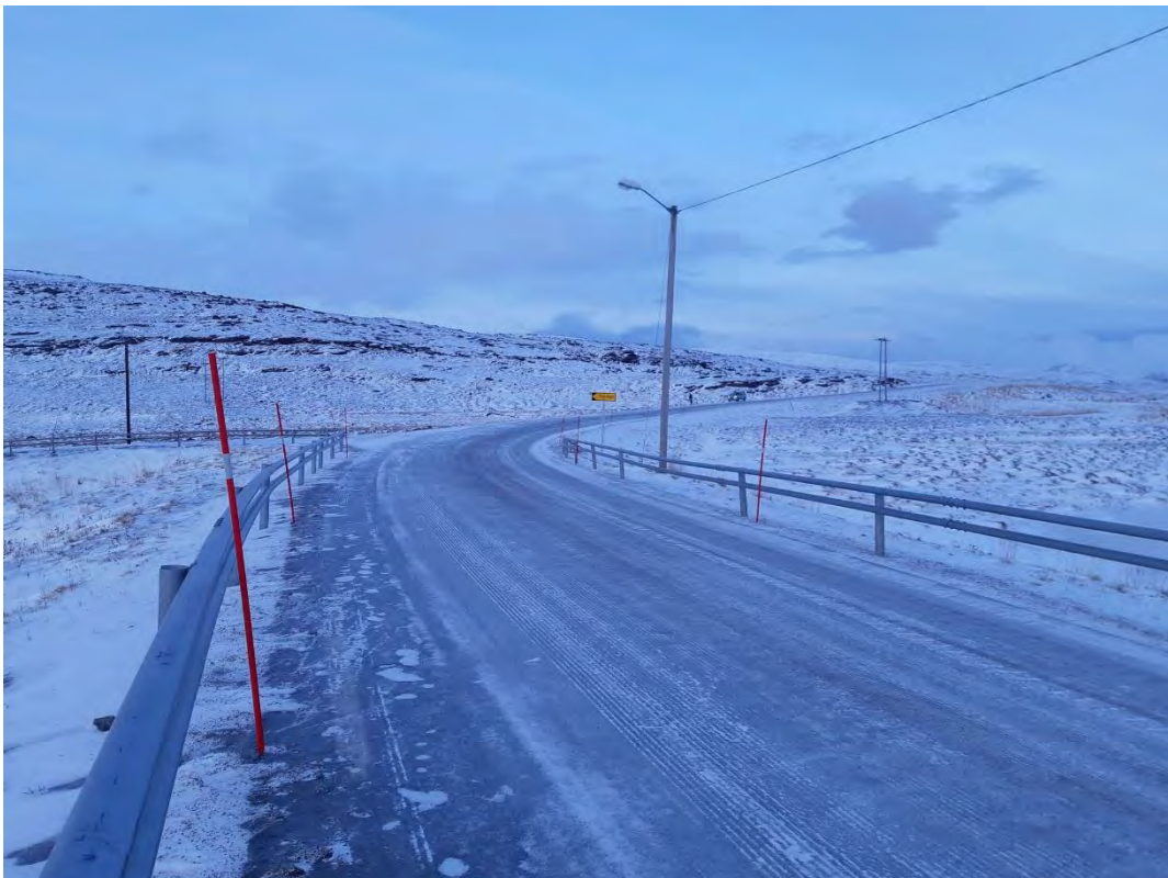
Bildet viser tilfredsstillende siktkrav sørgående retning.
